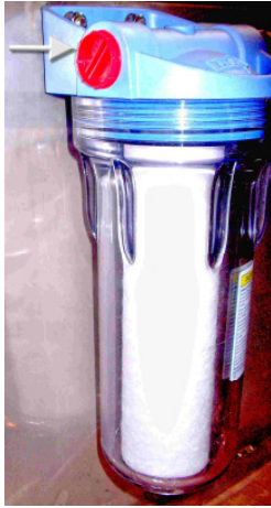
Wasseranschluss an Füllfilter G 3/4" (Innengewinde)
